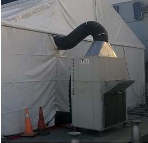
Generadores de combustión indirecta mediante gusano
